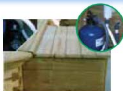
Casa de filtração
